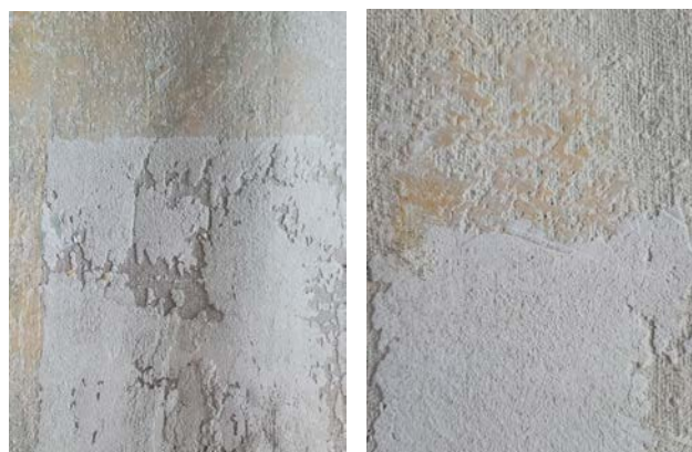
Рис. 5. Поступове зняття тиньку з основи
