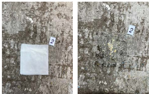
Рис. 2. Підбір методу зняття тиньку. Проба № 2
