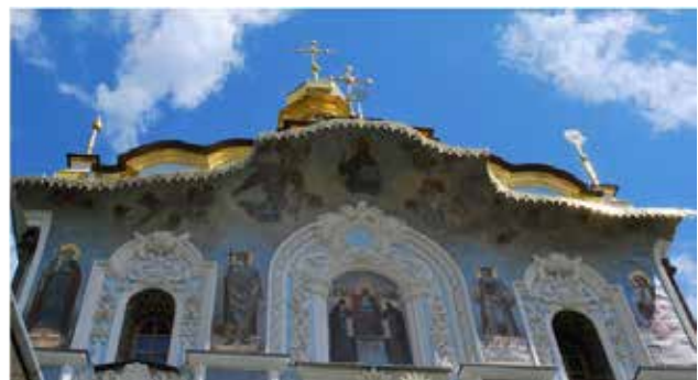
Іл. 11. Західний фасад Троїцької надбрамної церкви Києво-Печерської лаври. Фрагмент. Фото С. Оляніної
