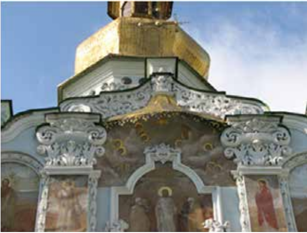
Іл. 12. Східний фасад Троїцької надбрамної церкви Києво-Печерської лаври. Фрагмент. Фото В. Зайцевої
