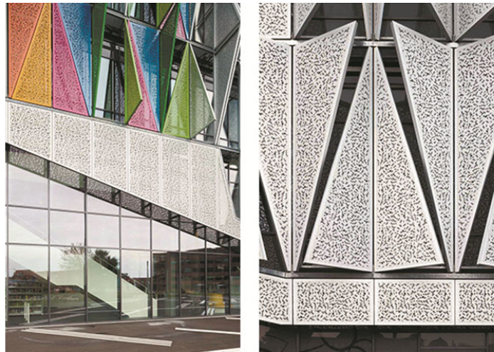
Іл. 17. Університет Південної Данії, Колдінг Кампус, фрагменти фасадів з перфорованими елементами-жалюзі. Колдінг, Данія. Матеріал алюміній. 2014
